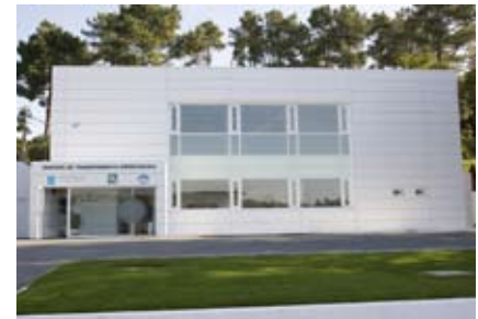
O novo edificio da UTE conta con laboratorio, sala de extraccións, oficinas e salas para conferencias e cursos
